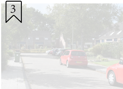
a) rijweg van betonklinkers met parkeren op straat, stoep van betontegels aan beide zijden
