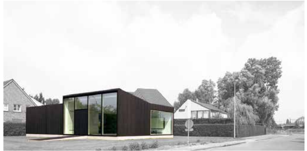
Werkdeel duidelijk zichtbaar
