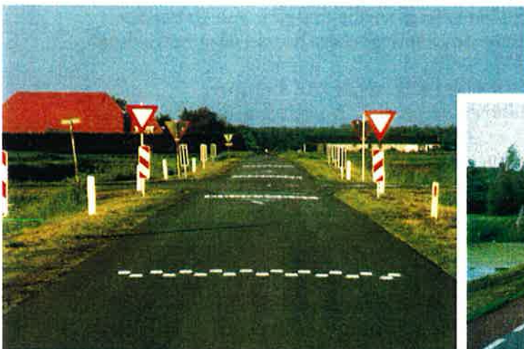
wegdekreflectoren ter hoogte van het kruisingsvlak ↓
