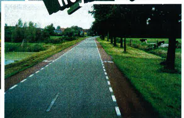
↑ geen middenbelijning, fietsstroken aan weerszijden van het wegvak
