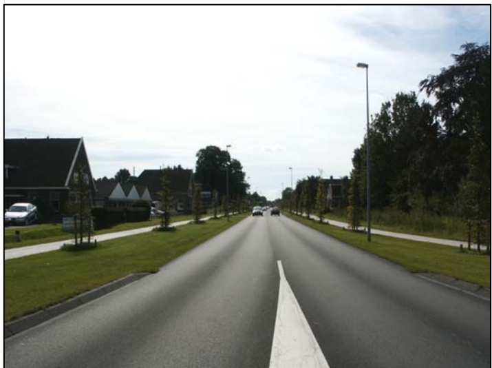
Foto 6: Asserstraat in Vries: primaire structuur
