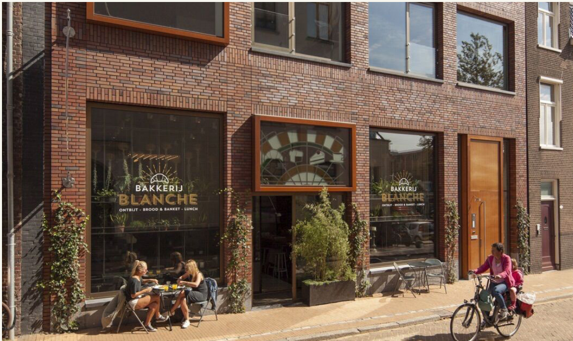
Grote puien en ruimte voor groen langs de gevel
