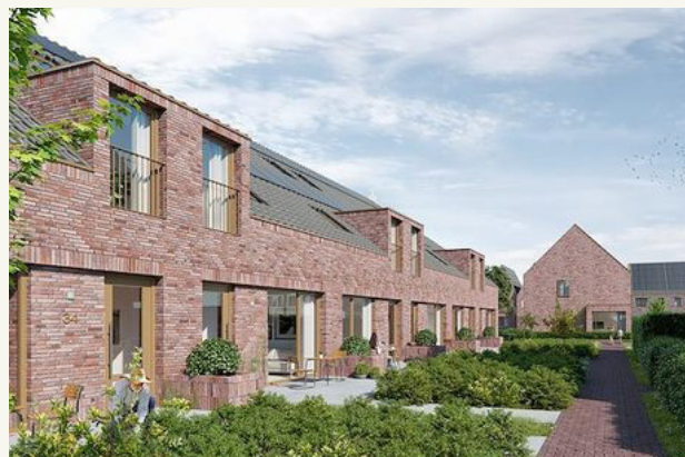
Dakkapel geïntegreerd in de gevel
