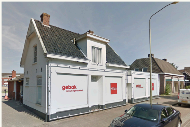
Referentie naar oorspronkelijke bebouwing
