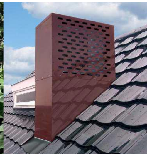
Figuur 7: Buitendeel op het dak als 'schoorsteen'
