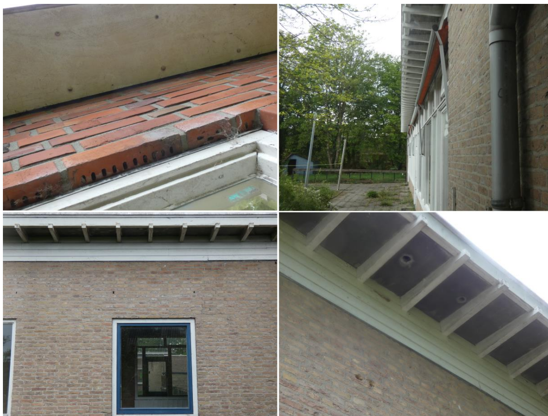
Afbeelding 5.3 Potentiële verblijfplaatsen vleermuizen (spleten langs dakrand, onder zonnewering, open stootvoegen en gaten in de dakrand)
