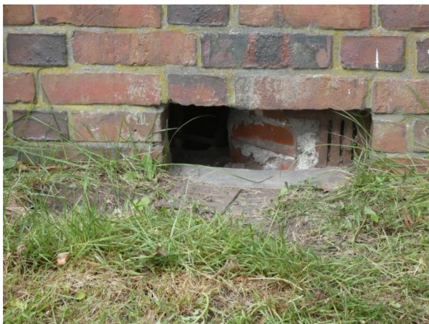
Afbeelding 5.2 Opening in voorgevel 'turnzaal' waardoor bijvoorbeeld een steenmarter toegang heeft tot de kruipruimte van het gebouw
