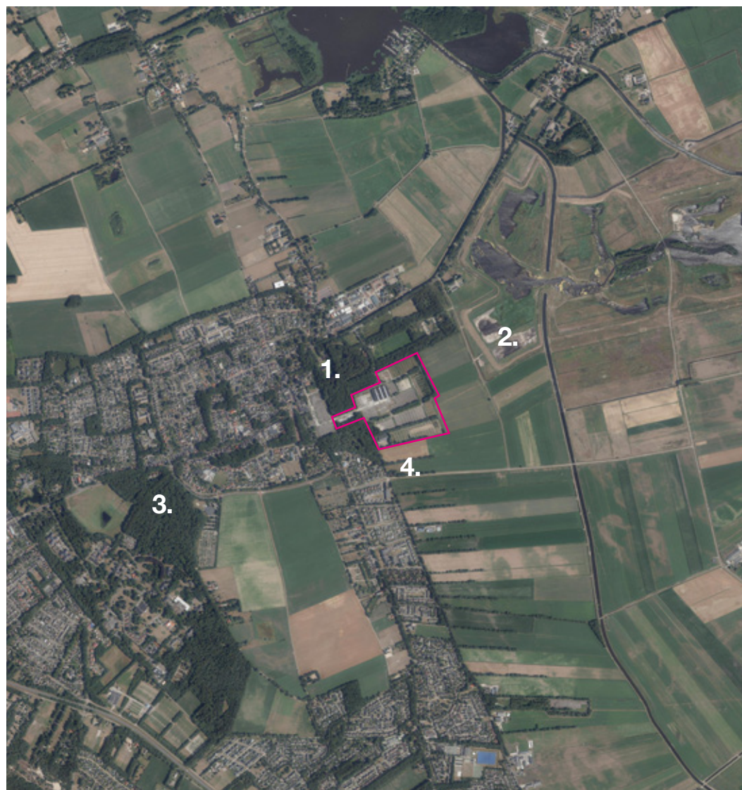
Luchtfoto achterzijde Laarhove
