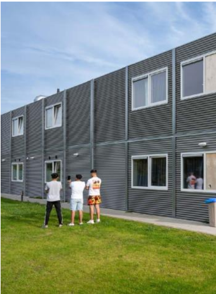
Figuur 4.1. Voorbeeld tijdelijke unitbouw (bron: COA Vastgoedgids)
