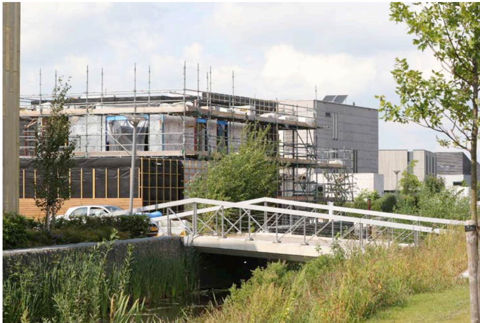
Woningen in aanbouw in Ter Borch
