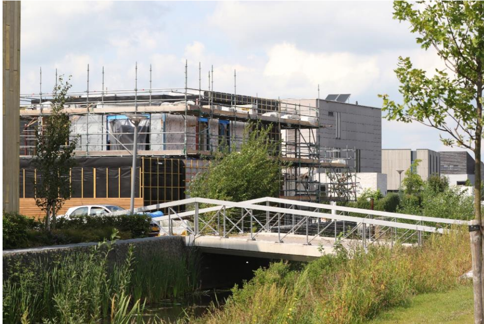
Woningen in aanbouw in Ter Borch
