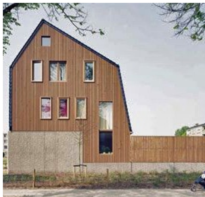
erfafscheiding aan de zijkant is mee-ontworpen met de woning
