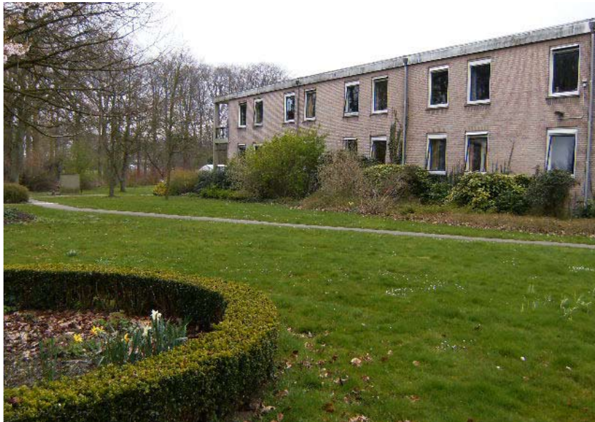
Slopen: aanbouw Hoog-Hullen
