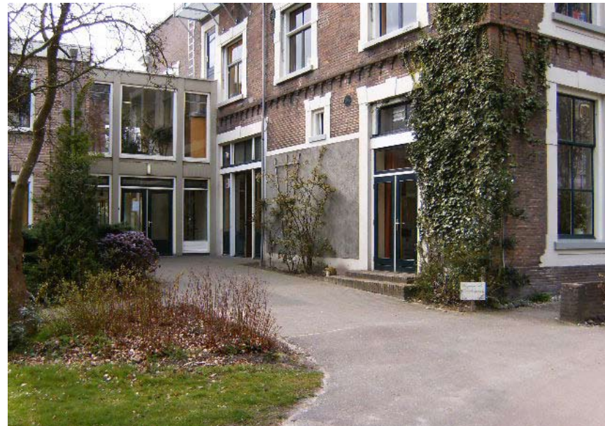
Slopen: overgang aanbouw Hoog-Hullen
