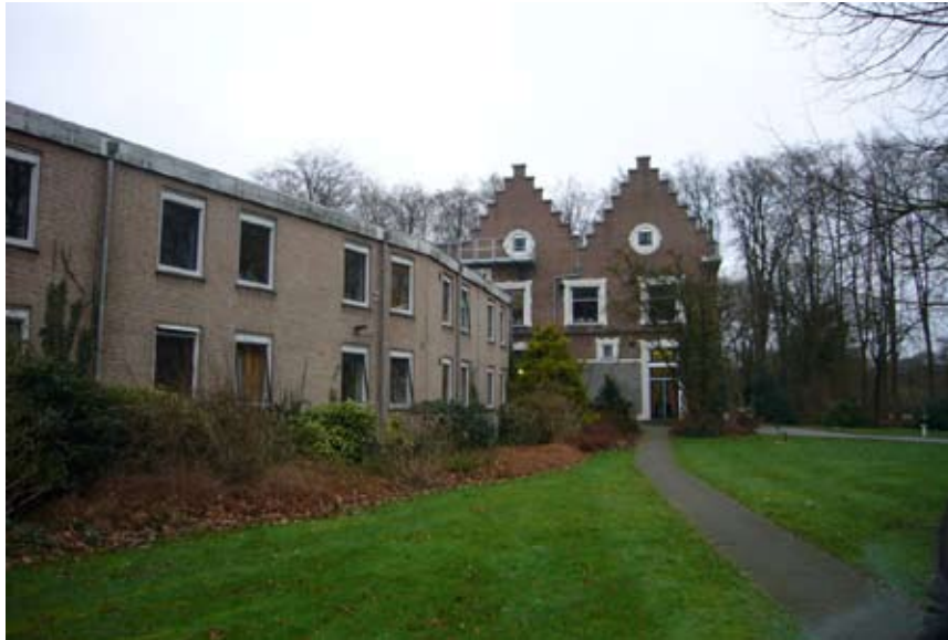
Slopen: aanbouw Hoog-Hullen
