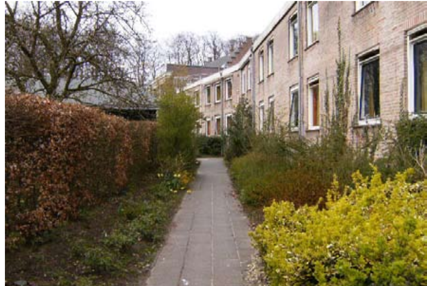
Slopen: aanbouw Hoog-Hullen (achterzijde)
