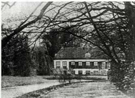
De achterzijde van het door brand verwoeste huis (foto DMA)
