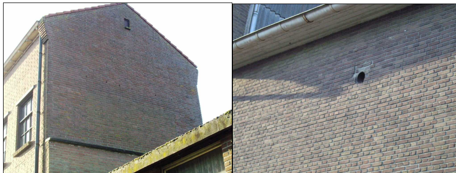
Stootvoegen in een van de gebouwen
