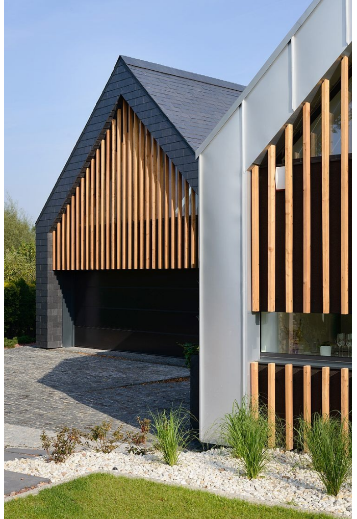
Zink, leisteen of vlakke grijze pan met natuurlijke invulling
