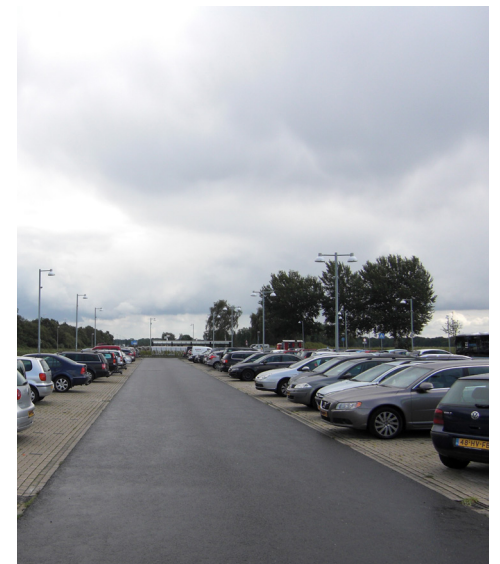
Bestaande P&R met asfalt en grijze betonsteen
