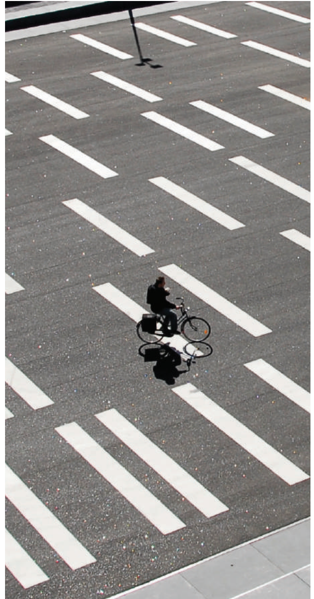
Olympische stadion Amsterdam, referentie glitterasfalt.
