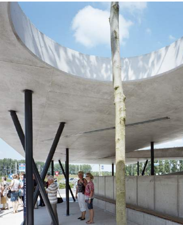
Referentie betonnenvloeren, transferium Haren, Onix
