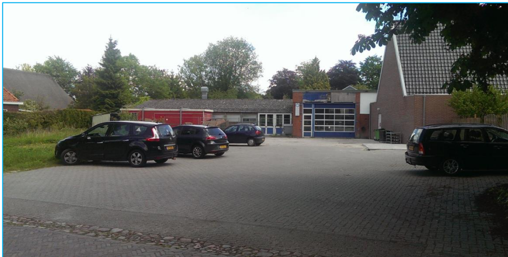
Zicht op locatie Koningstraat – bebouwing is gesloopt
