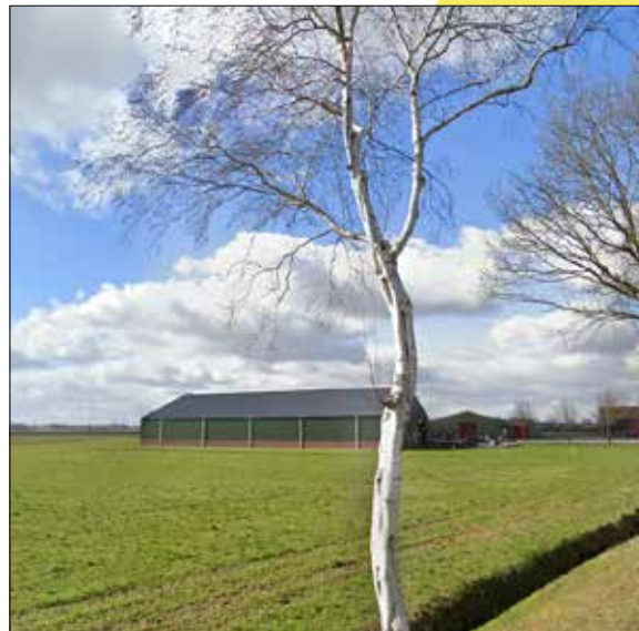
de schuur t.b.v. opslag en loonwerk
