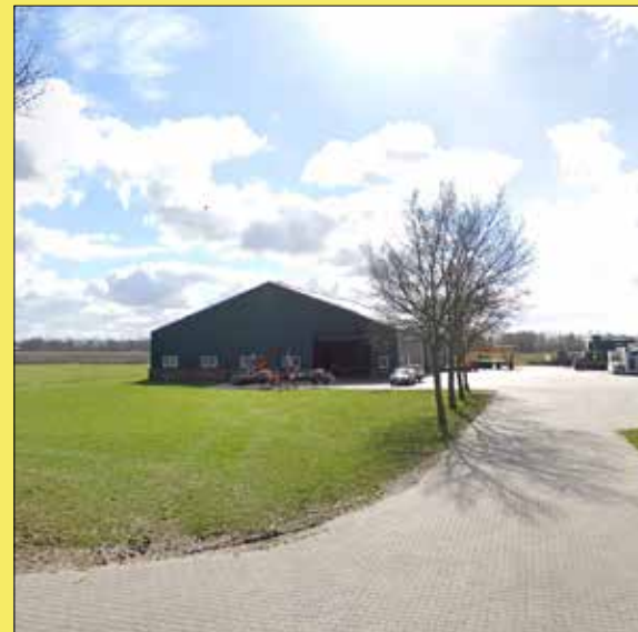
de schuur t.b.v. opslag en loonwerk
