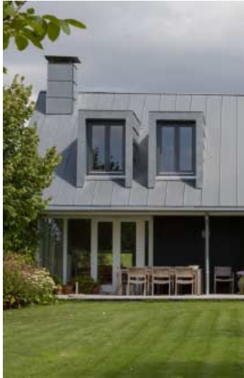
dak en dakkapel zink
