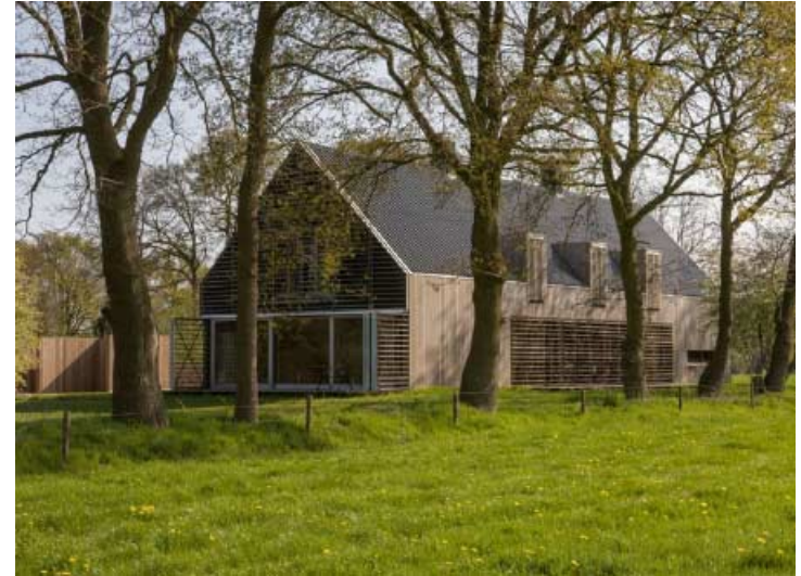
houten gevel, golfplaten dak, luiken, dakkapellen
