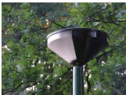
Figuur 3.4 Kegelvormige armatuur afgeschermd naar boven en naar achteren (bron: Bij12, 2017b).
