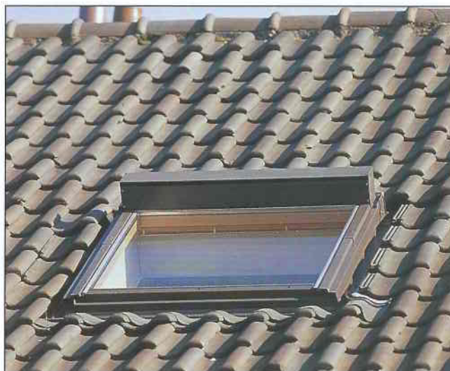
Suskast type AGV® gemonteerd op VELUX®-dakvenster
