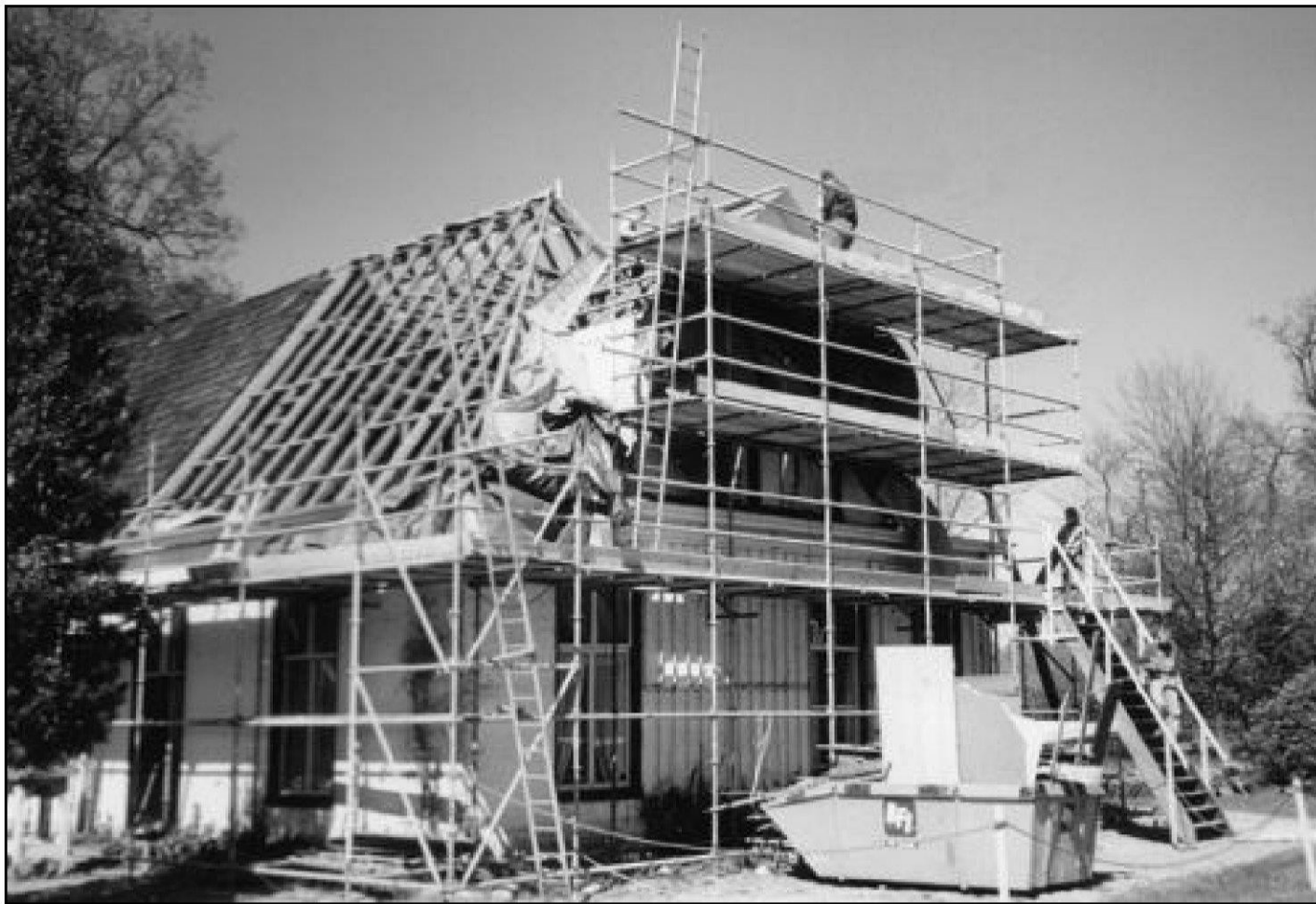
Het dak werd als eerste aangepakt (foto collectie Ginie Arends).
