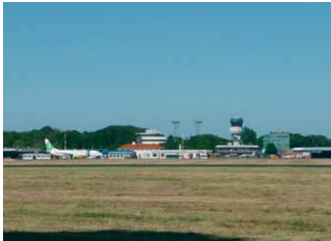
Baanverlenging en uitbreiding
