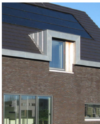
dakkapel geïntegreerd in volume, zonnepanelen in het dakvlak
