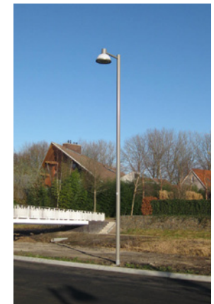
armatuur op 6 meter
