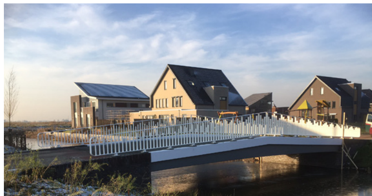
verbindingsbrug met knik, identiek aan de bruggen in Rietwijk Zuid
