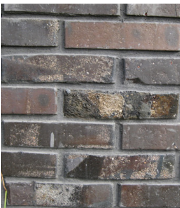
robuuste gebakken mestelsteen van de entreebrug en landhoofd verbindingsbrug
