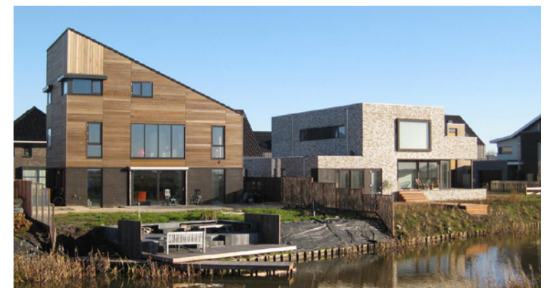
Madijkwoningen met plat dak en lessenaarsdak, gevel met houten delen
