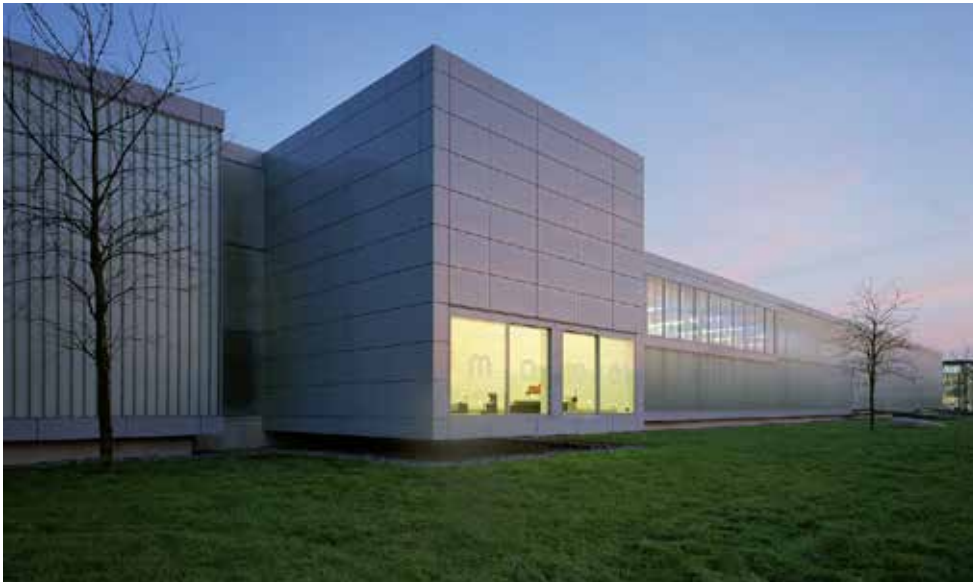
Langere eenheden hebben een verspringing naar voren of naar achteren in de gevel
