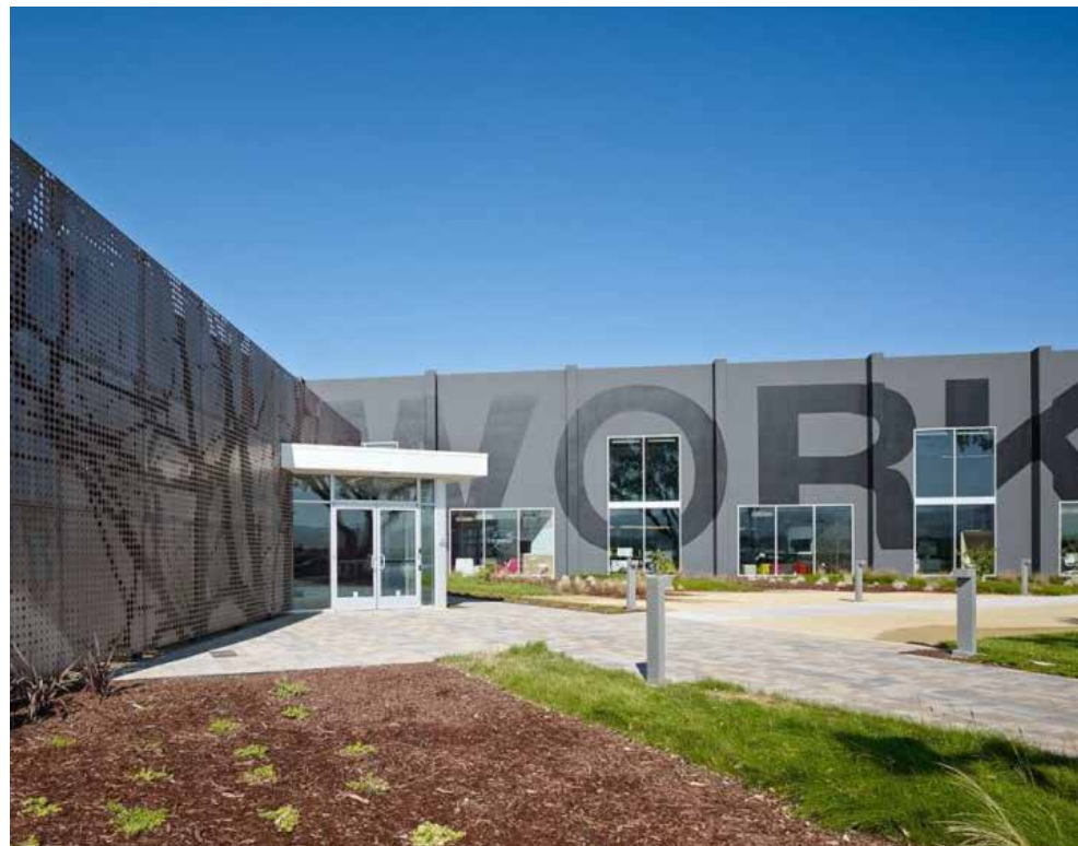
Reclame zit op de gevel niet los op het gebouw
