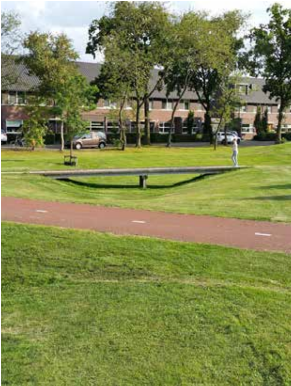
Vetraagde berging met loopbrug
