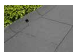
Platte daken (bitumen)
